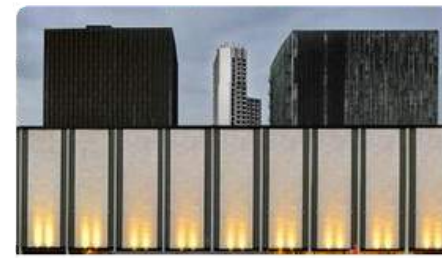
Nationaltheater Mannheim Allemagne
